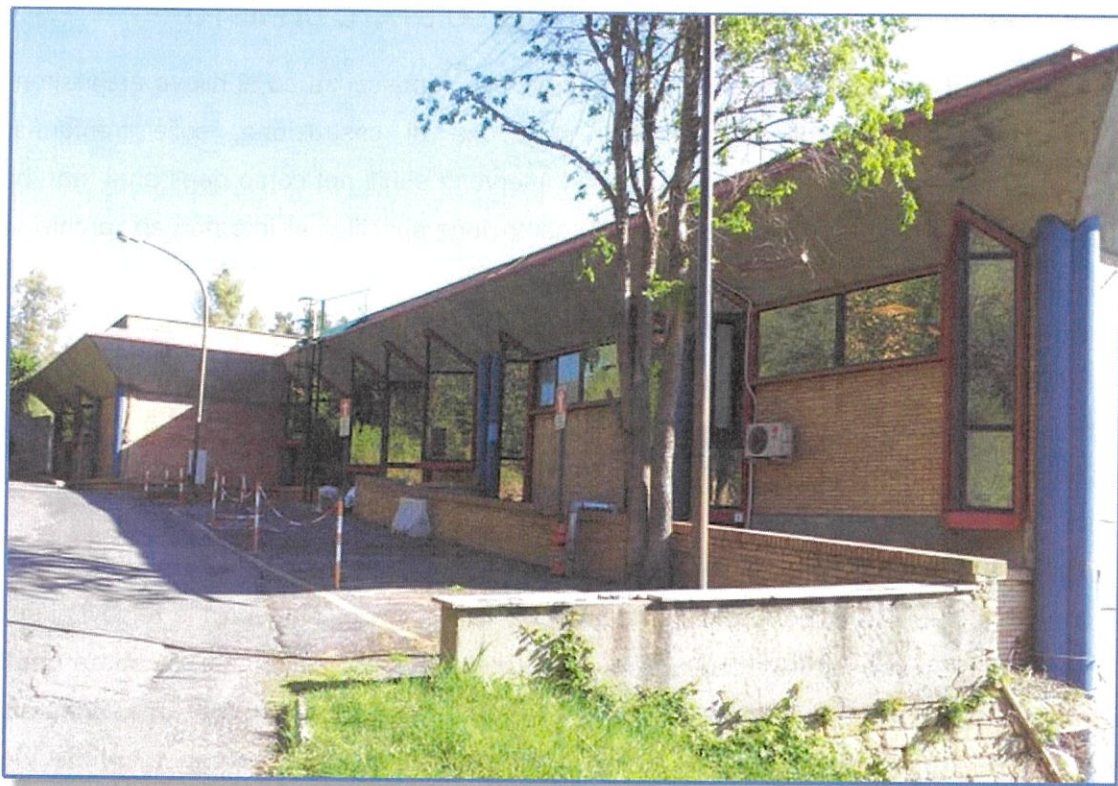
VISTA LATO OVEST – SU STRADA INTERNA (SALITA DI S.CARLO)
