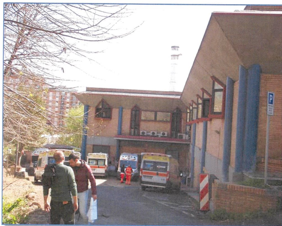
VISTA LATO EST – RAMPA INTERNA
