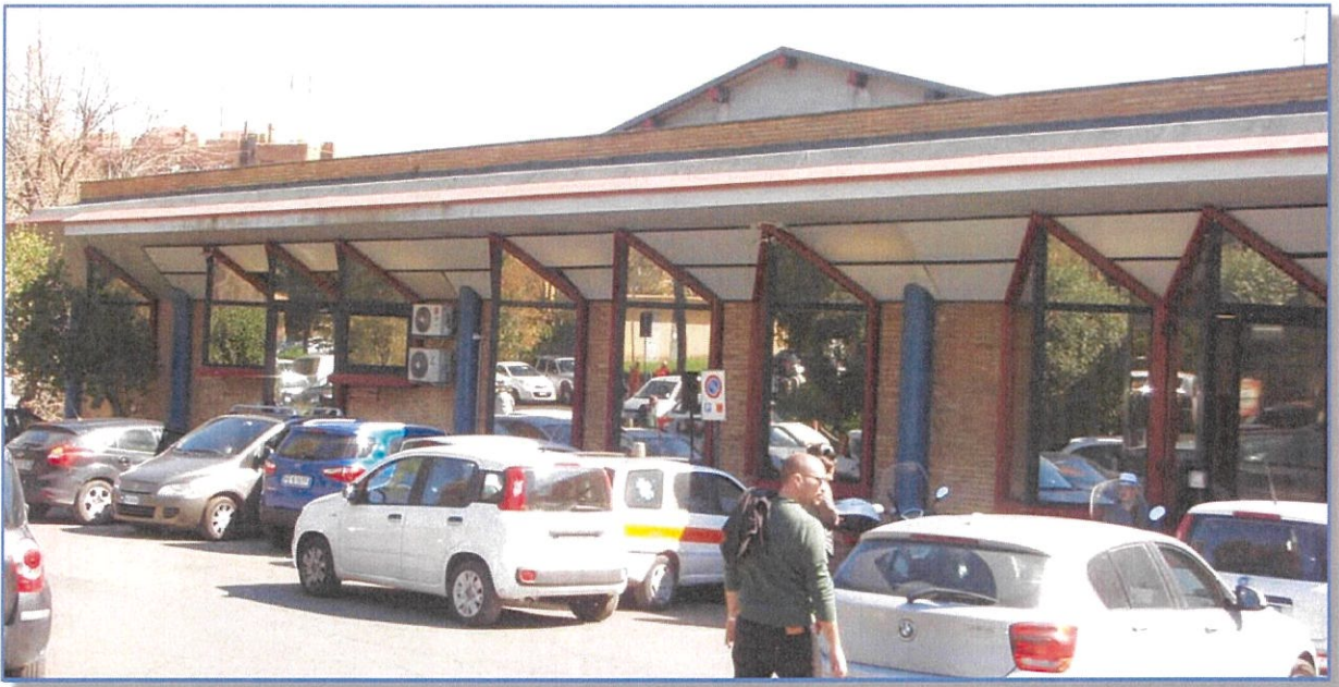
VISTA LATO NORD - PIAZZALE SUPERIORE DI INGRESSO.
