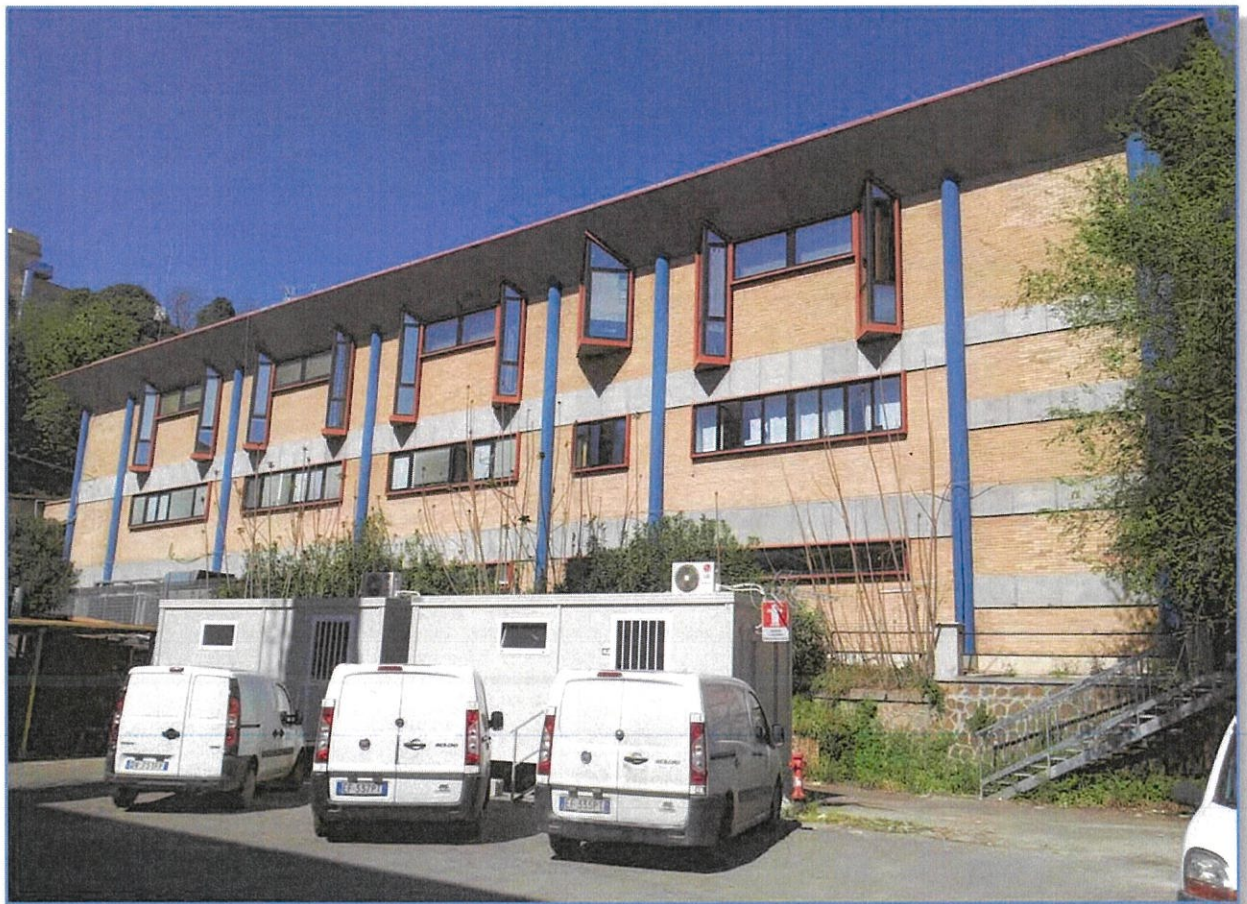
VISTA LATO SUD - PIAZZALE INFERIORE.
